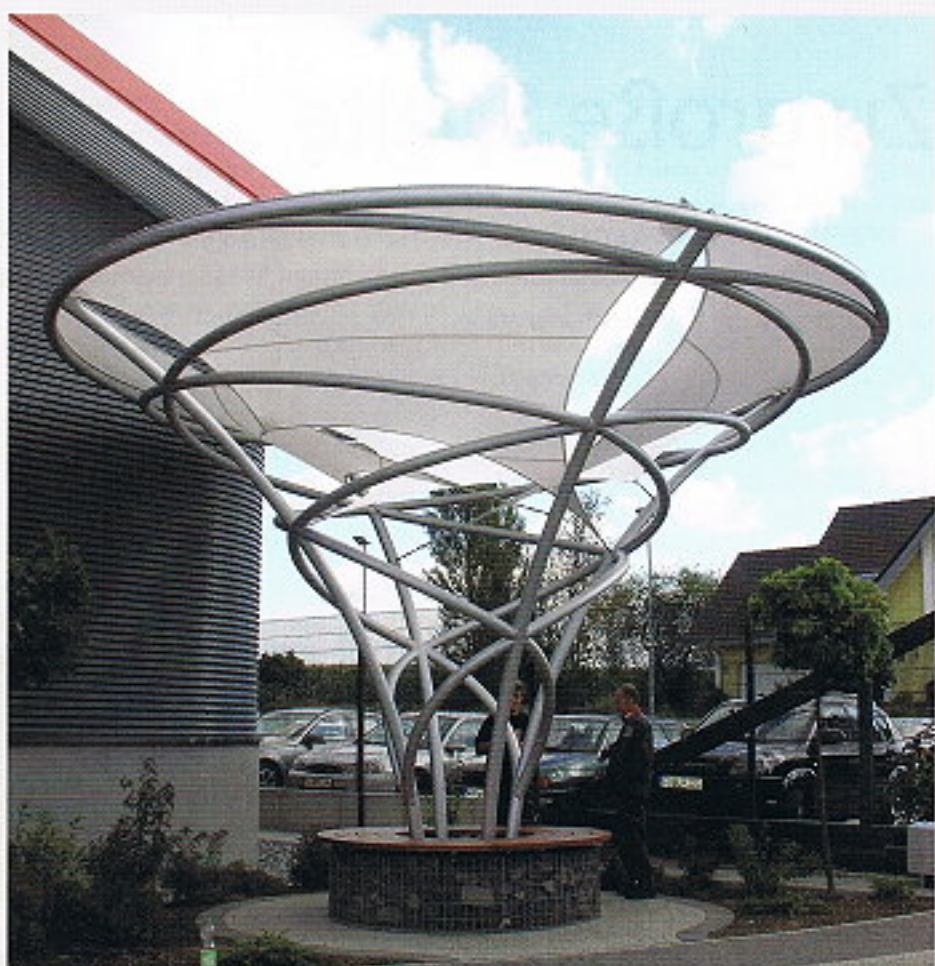
Trotz der komplizierten Form ist der „Leuchtturm“ in der Ansicht und Aufsicht streng symmetrisch angelegt.
