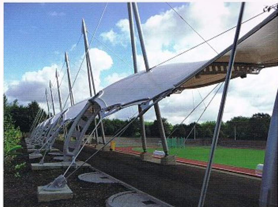
Bei der Tribünenüberdachung für die „Vestische Kampfbahn“ Gladbeck wurde auf die Vorteile textiler Architektur gesetzt.
