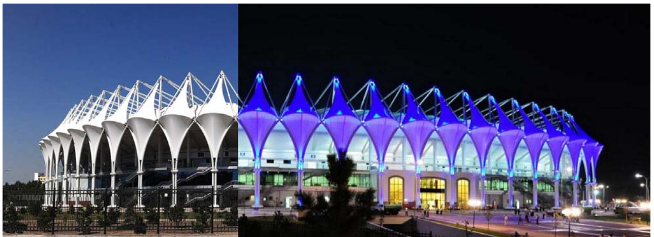
Die 64 hinterleuchteten Fassadensegel mit bis zu 34 m Höhe zitieren die "Flammen des Orients"
